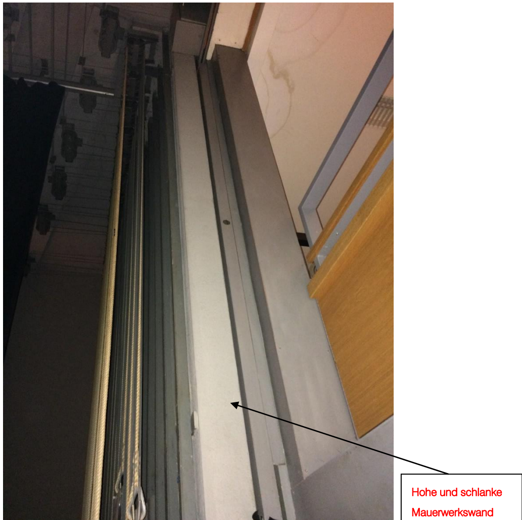
Abbildung 9: Hohe und schlanke Mauerwerkswand
