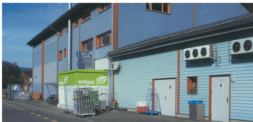
Abb. 14 Bestehende Vorplatzsituation entlang der Gemeindestrasse
