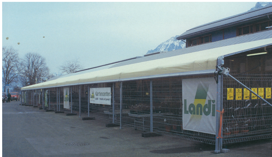
Abb. 12 Bestehende permanente Aussenverkaufsfläche mit beweglichem Witterungsschutz
