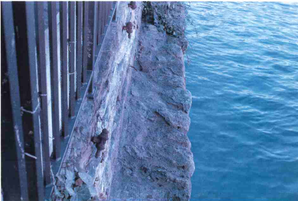
Betonierter Sockel im Flussbett, Detail
