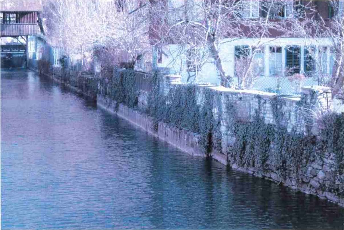
Betonierter Sockel im Flussbett
