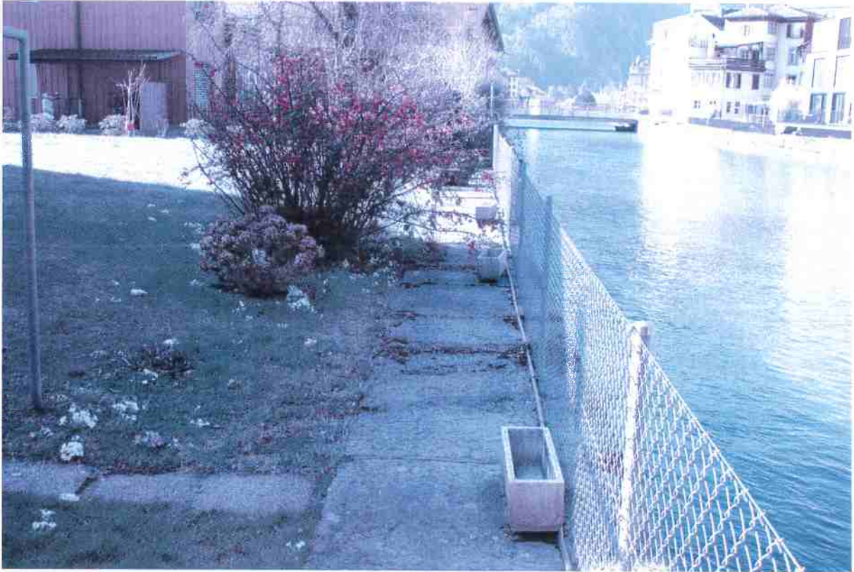
Bestehender Weg entlang dem Ufer, Bereich Parzelle 556
