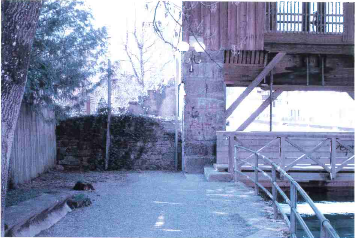
Trockensteinmauer auf Parzelle 556 / Schleuse, Ansicht Nord vom bestehenden Uferweg
