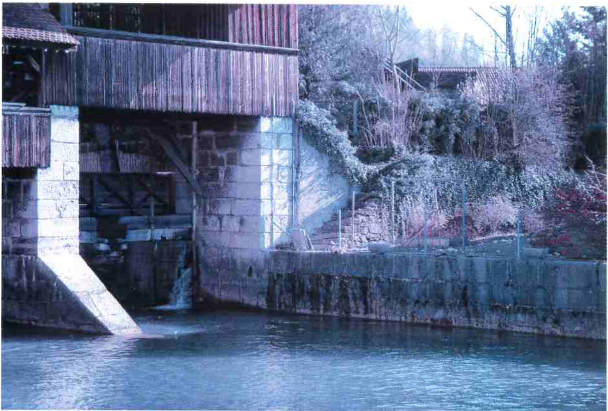
Trockensteinmauer mit Rampe auf Parzelle 556 / Schleuse, Ansicht Süd
