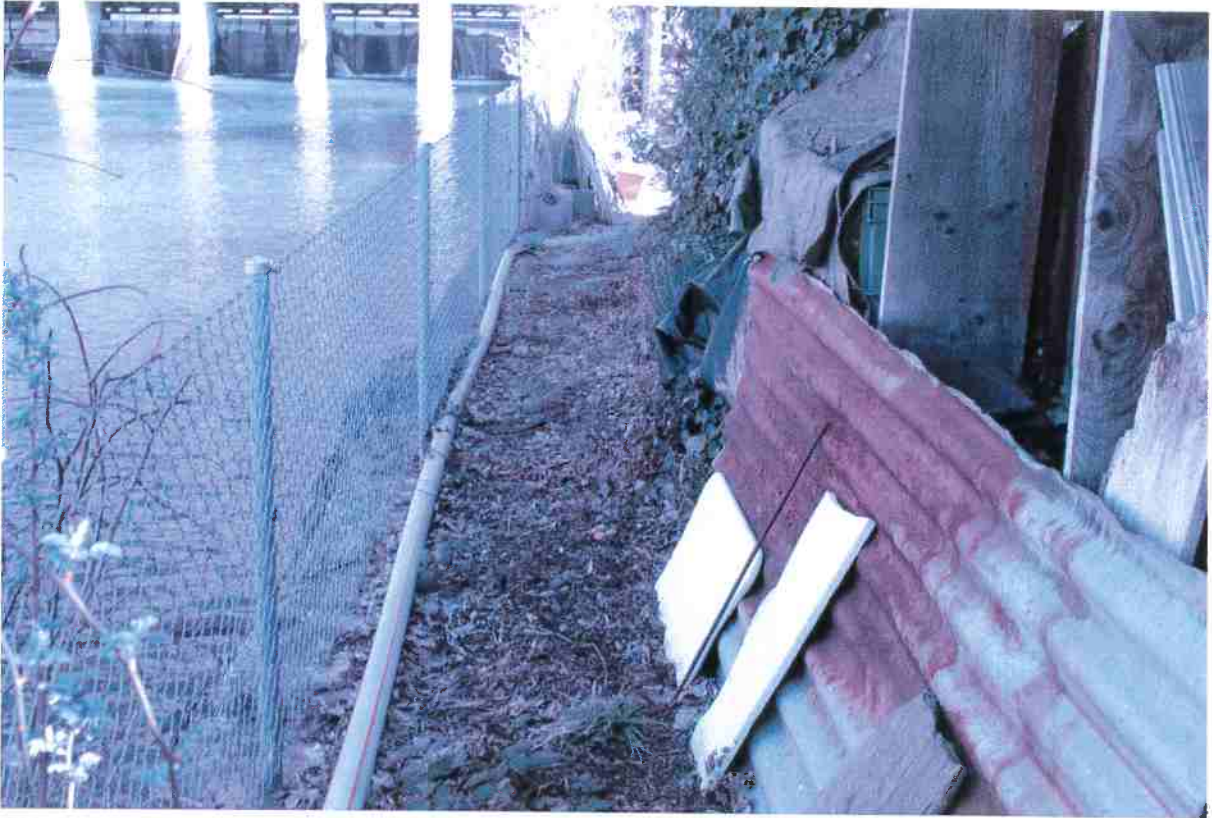
Bestehender Weg entlang dem Ufer, Bereich Parzelle 1975
