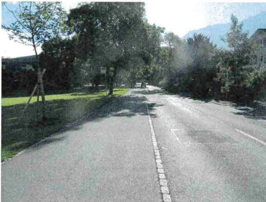
Abbildung 5, Haltestelle Sonnenhof Richtung B, gegen die Fahrtrichtung
