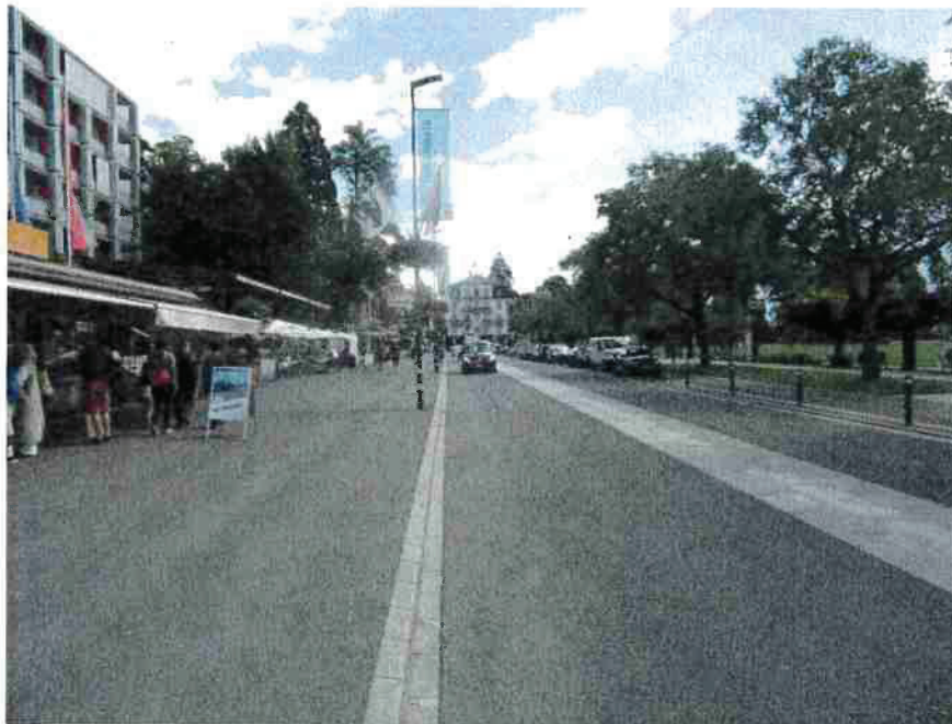
Abbildung 29, Haltestelle Kursaal Richtung B, gegen die Fahrtrichtung
